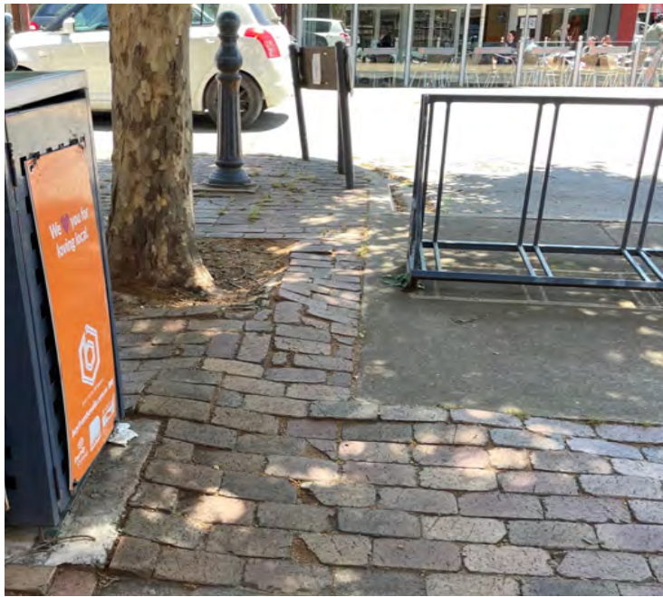
UNEVEN PAVEMENT SURFACE
